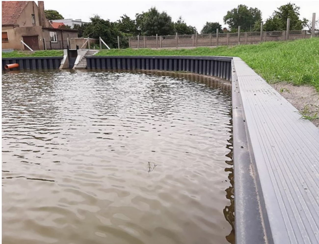
OKOLICE POZNANIA, POLSKA: REWITALIZACJA ZBIORNIKA RETENCYJNEGO - STABILIZACJA BRZEGÓW ZA POMOCĄ OPASKI Z GRODZIC WINYLOWYCH WYKOŃCZONEJ OCZEPEM I MODERNIZACJA UPUSTU WODY POPRZECZ MONTAŻ ZASTAWKI RETENCYJNEJ W ISTNIEJĄCYM JAZIE.
