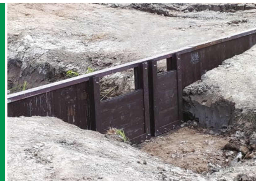
SZWECJA: PIERWSZA WINYLOWA ZASTAWKA MAŁEJ RETENCJI ZAINSTALOWANA POZA GRANICAMI POLSKI.
