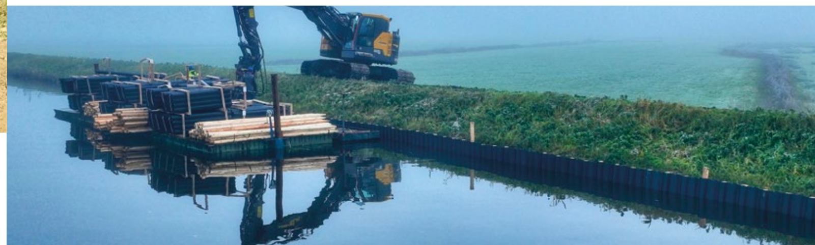
HOLANDIA: ZABEZPIECZENIE BRZEGU ZBIORNIKA WODNEGO, WYKONANE Z PROFILI M-HEX WZMOCNIONYCH PALAMI DREWNIANYMI.
