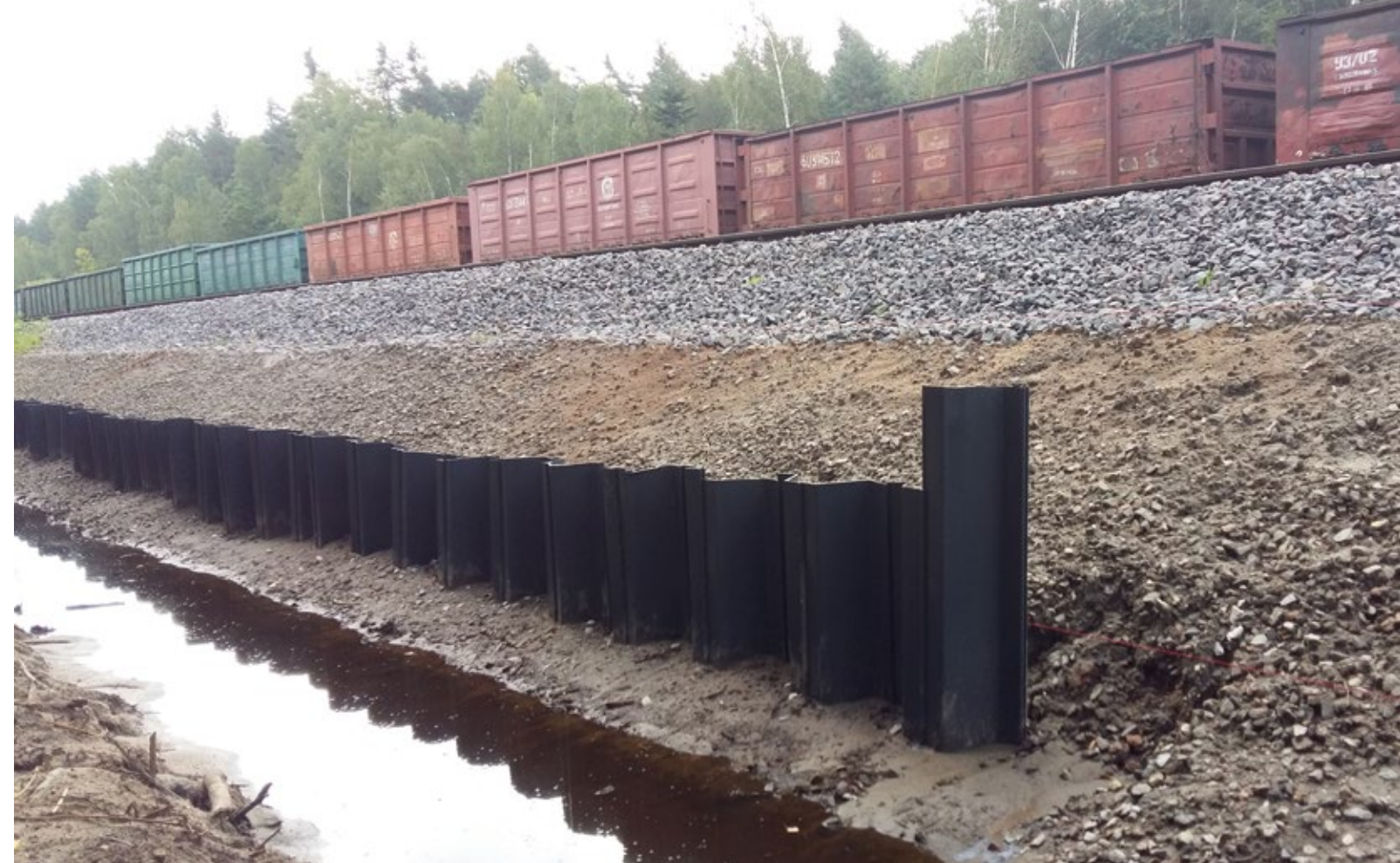
STALOWA WOLA, POLSKA: STABILIZACJA NASYPU KOLEJOWEGO.
