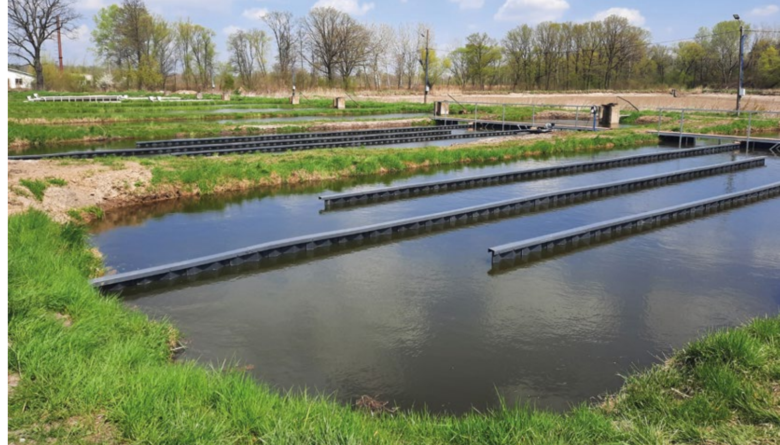
GRODZICE WINYLOWE ORAZ DESKI TARASOWE TERRADECK WYKORZYSTANO PRZY BUDOWIE INFRASTRUKTURY W OBRĘBIE KOMPLEKSU EKSPERYMENTALNYCH STAWÓW RYBACKICH W ŻABIŃCU, POLSKA.
