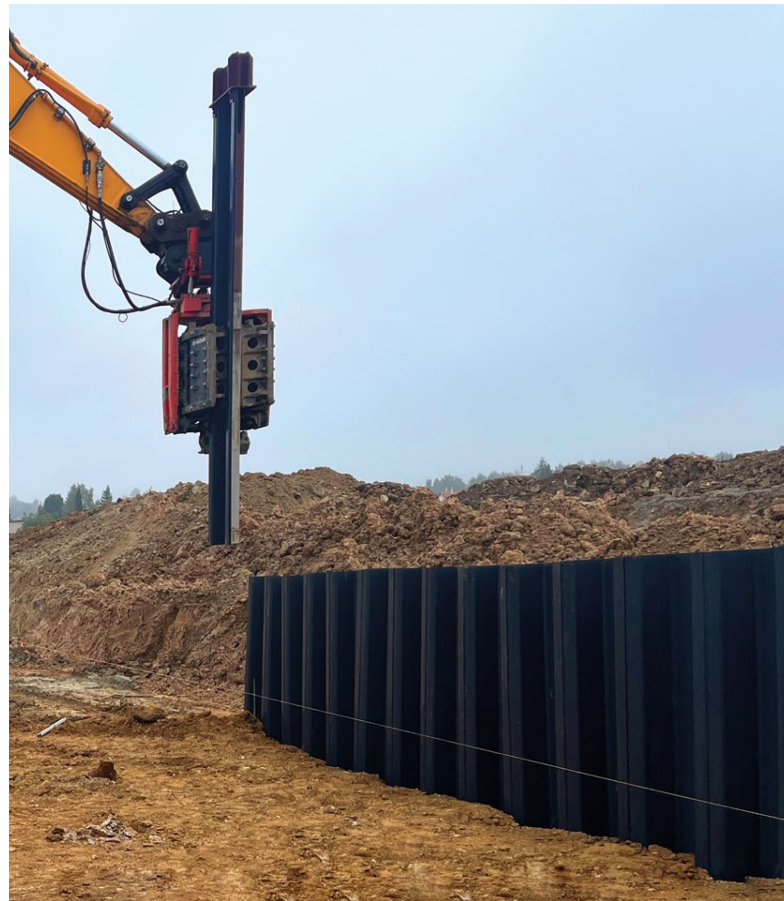
BUDZIEJOWICE, CZECHY: MONTAŻ GRODZIC WINYLOWYCH W TRUDNYCH WARUNKACH GRUNTOWYCH.
