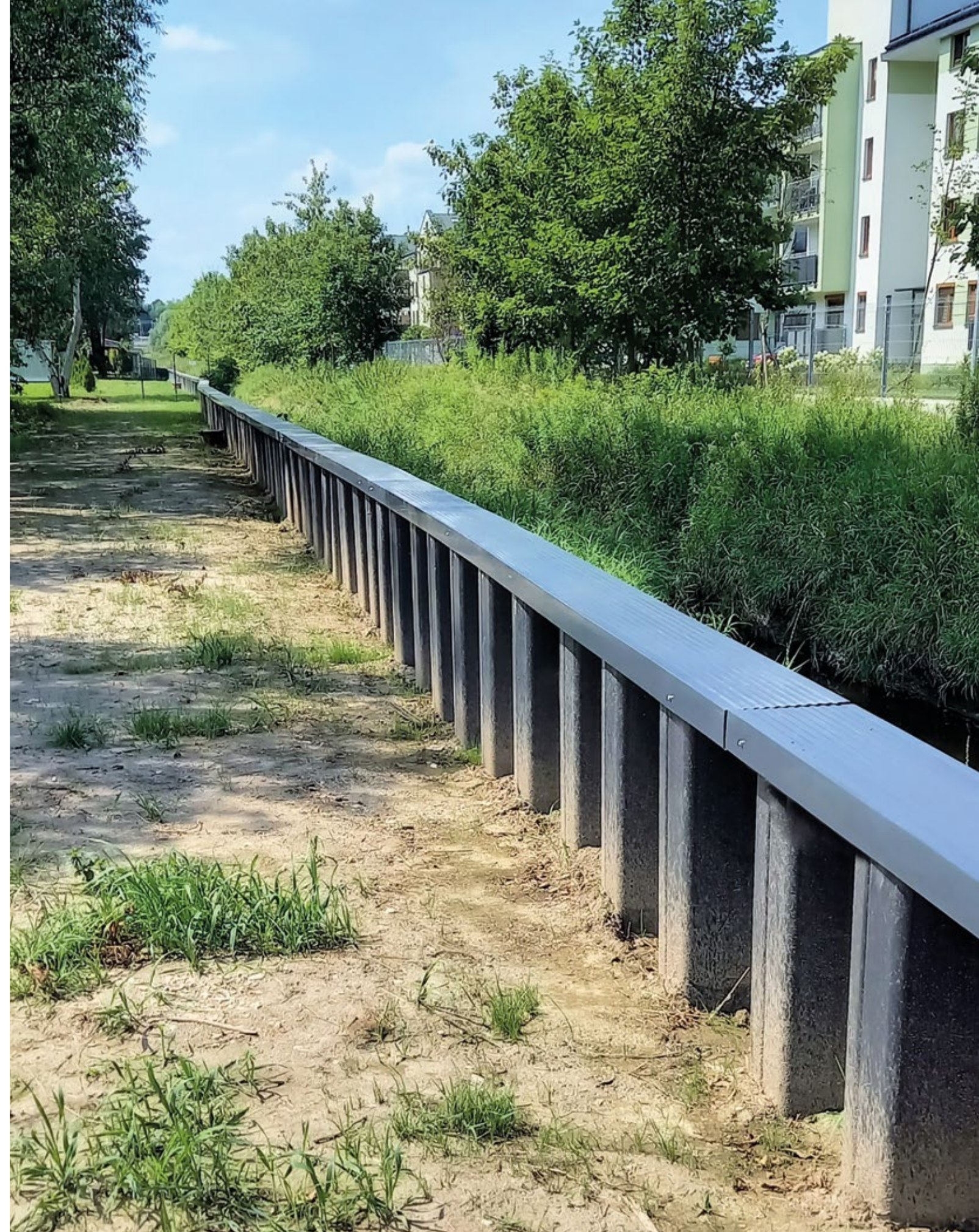
KRAKÓW, POLSKA: GRODZICE WINYLOWE JAKO ELEMENT OCHRONY PRZECIWPOWODZIOWEJ NA OBSZARZE O GĘSTEJ ZABUDOWIE.
