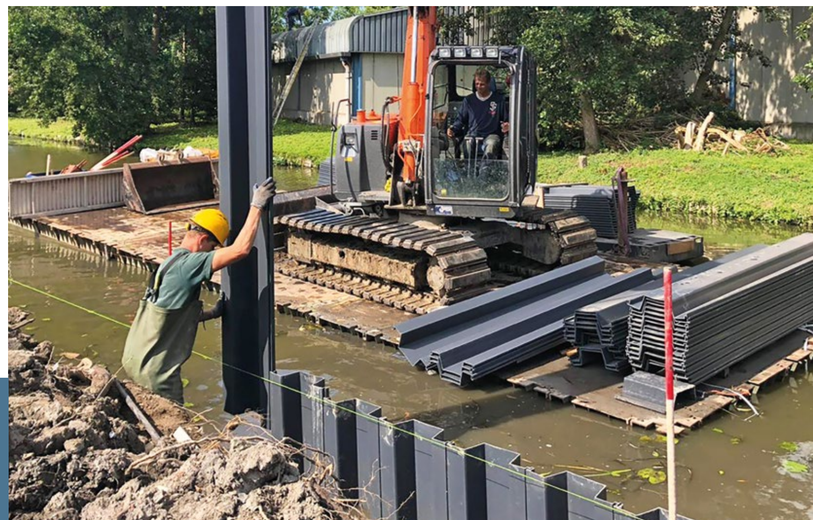
DELFT, HOLANDIA: ZABEZPIECZENIE BRZEGÓW KANAŁU.
