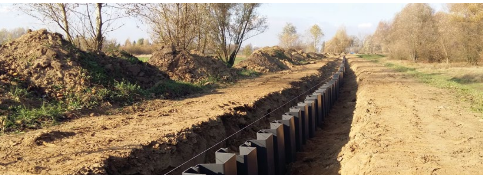
GIZAŁKI, POLSKA: DOSZCZELNIENIE I WZMOCNIENIE WAŁU PRZECIWPOWODZIOWEGO.
