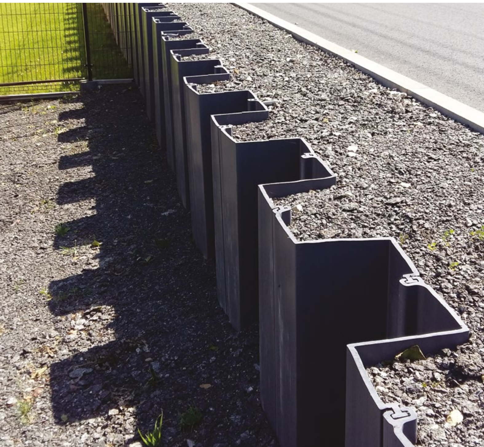
MARKLOWICE, POLSKA: ŚCIANA OPOROWA TWORZĄCA KONSTRUKCJĘ DROGI.
