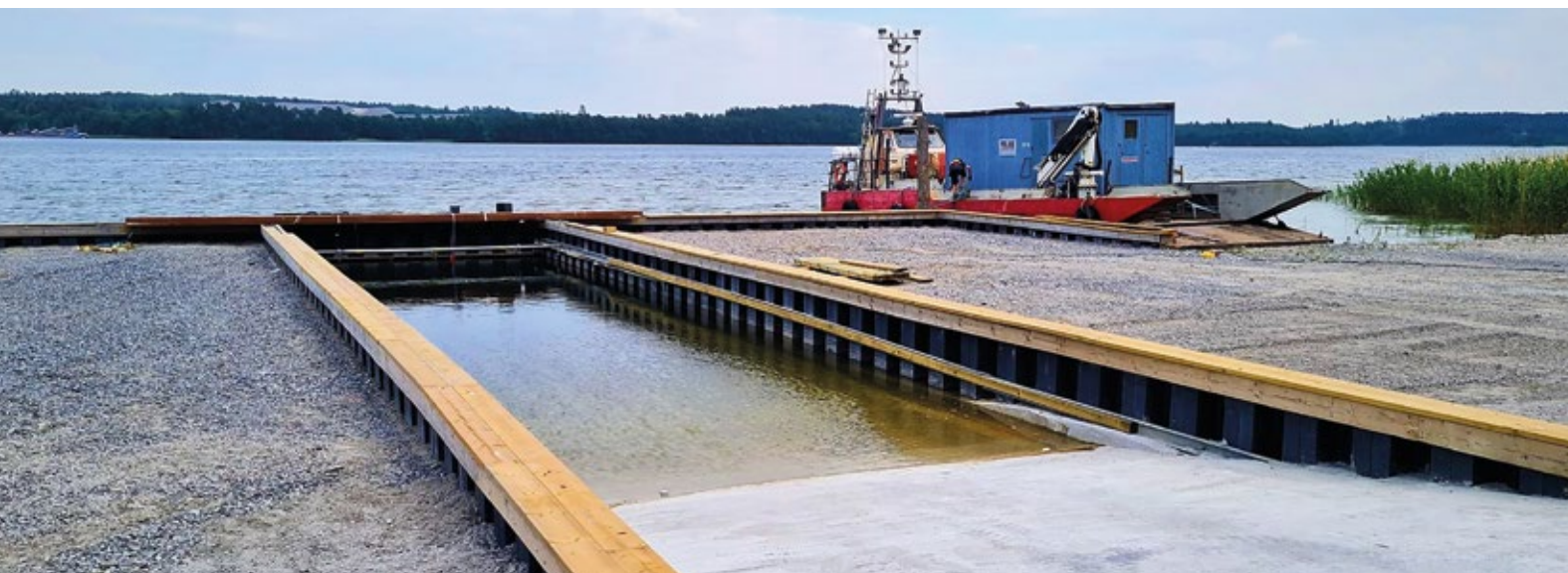
UPPSALA, SZWECJA: GRODZICE HYBRYDOWE SUPERLOCK WYKORZYSTANE DO BUDOWY RAMPY DO WODOWANIA ŁÓDZI.
