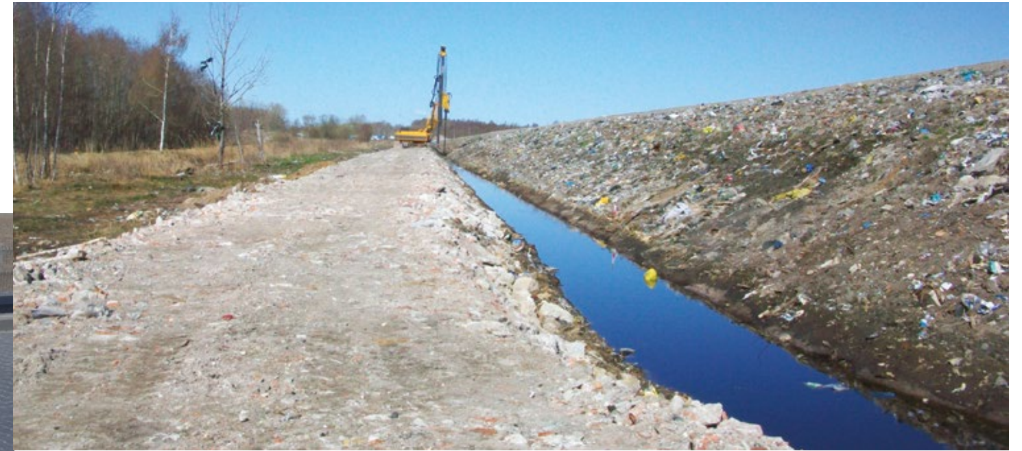
PARNU, ESTONIA: REALIZACJA PRZESŁONY FILTRACYJNEJ PRZY WYSYPISKU ODPADÓW CHEMICZNYCH PO PRZEMYSŁE GARBARSKIM.
