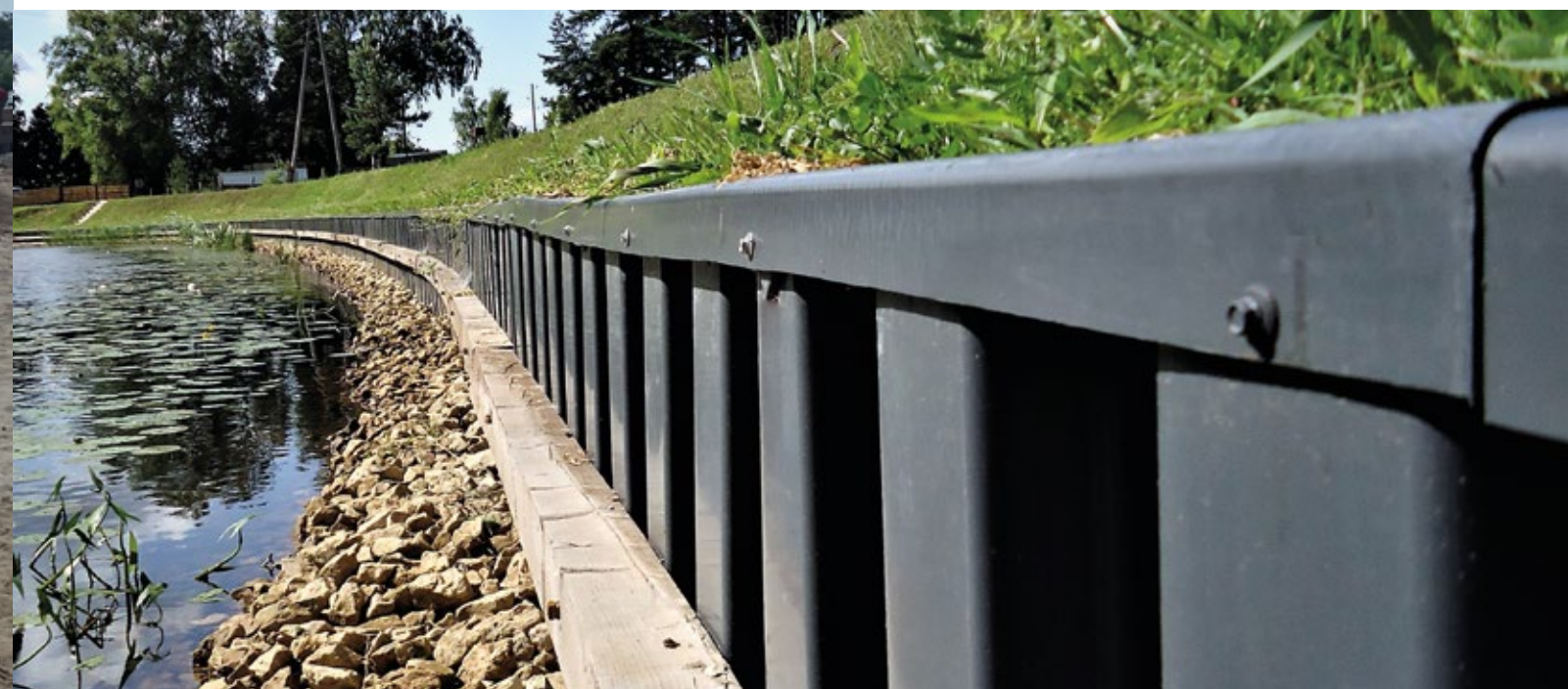
CARNIKAVA, ŁOTWA: ZABEZPIECZENIE BRZEGU ZBIORNIKA WODNEGO.
