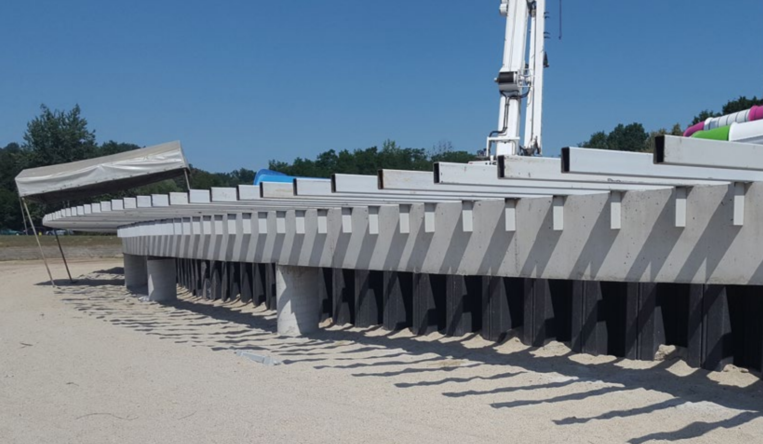
NYSA, POLSKA: GRODZICE WINYLOWE ECOLOCK WYKORZYSTANO PRZY BUDOWIE KAPIELISKA MIEJSKIEGO.
