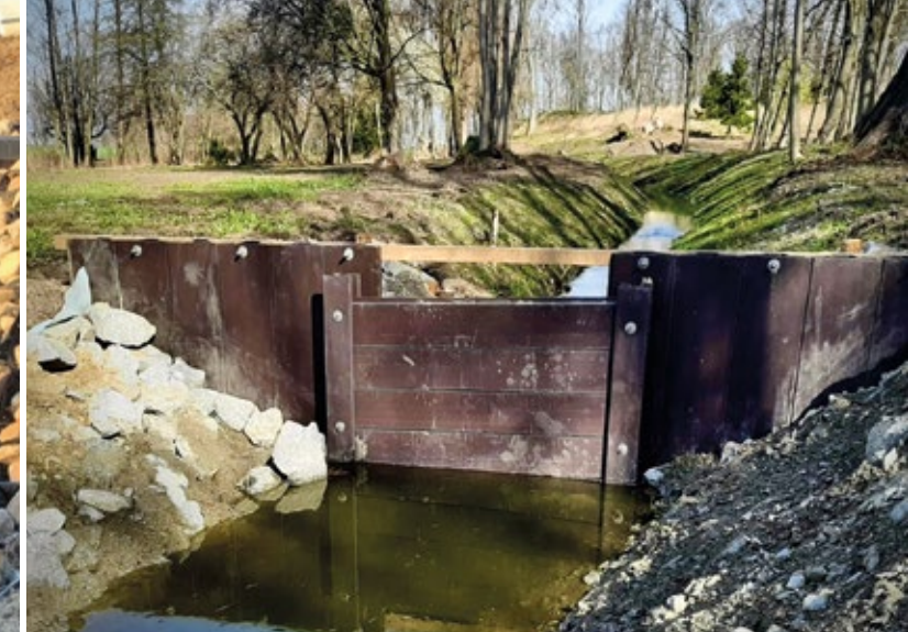
OKOLICE JAROCINA, POLSKA: SYSTEM WINYLOWYCH ZASTAWEK MAŁEJ RETENCJI W PROJEKCIE REWITALIZACJI MIEJSKICH TERENÓW REKREACYJNYCH.
