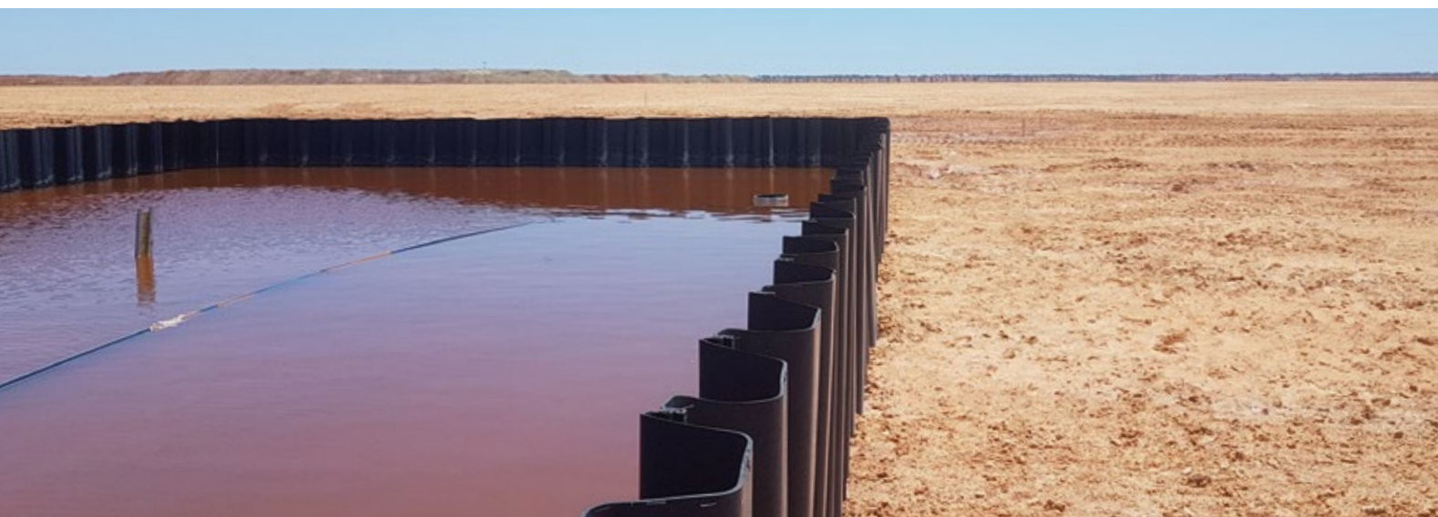
WILUNA, AUSTRALIA: ZBIORNIK NA SOLANKĘ ZBUDOWANY Z GRODZIC WINYLOWYCH Z INTEGRALNĄ USZCZELKĄ Z MIĘKKIEGO PVC.
