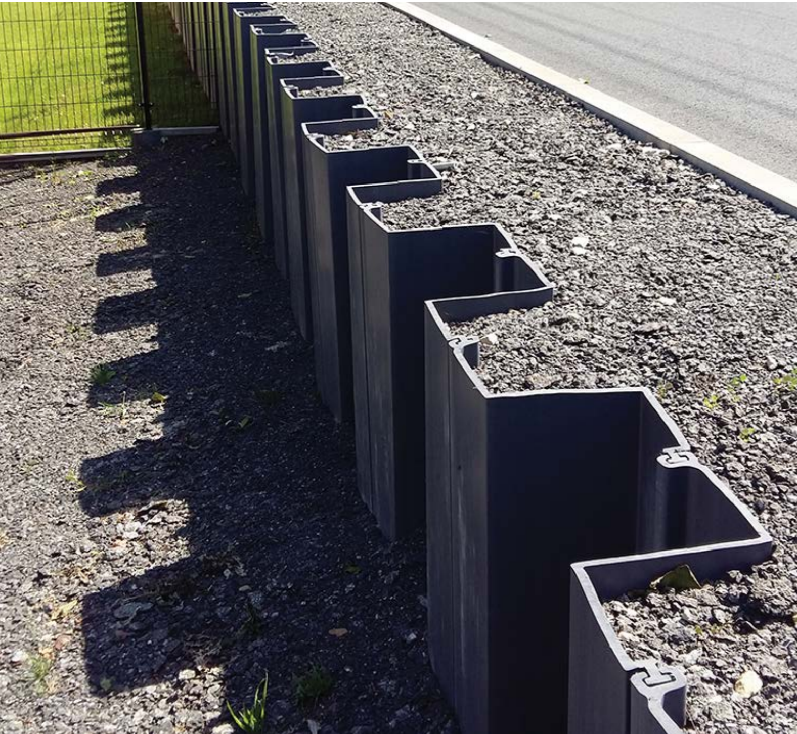
MARKLOWICE, POLSKA: ŚCIANA OPOROWA TWORZĄCA KONSTRUKCJĘ DROGI.
