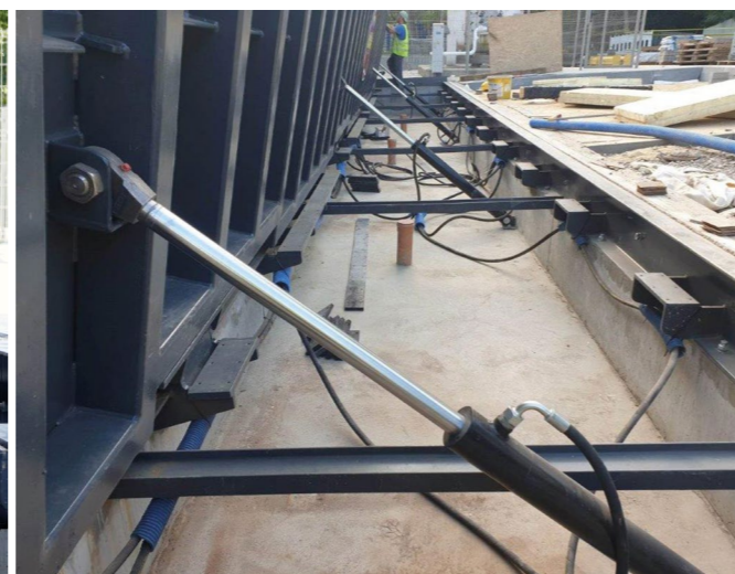
ZAPORA W TRAKCIE MONTAŻU
