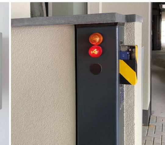
LAMPKI OSTRZEGAWCZE I WYŁĄCZNIK KRAŃCOWY ZAMKNIĘCIA ZAPÓR
